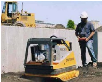
Figur 28: Fjernstyrt "hoppetusse" uten vibrasjons- eksponering for operatøren.
